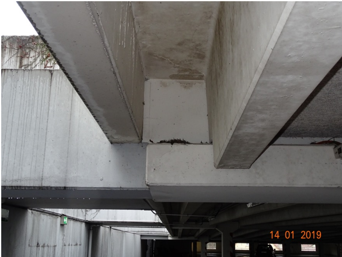
Abb. 13: Parkdeck untere Ebene, für Fledermäuse geeignete Spaltenquartiere sind nicht vorhanden, Brutmöglichkeiten für Vögel sind auf Betonträgern vorhanden, die untere Ebene ist über die Auffahrten und die Abfahrt von der oberen Ebene für Vögel und Fledermäuse frei zugänglich
