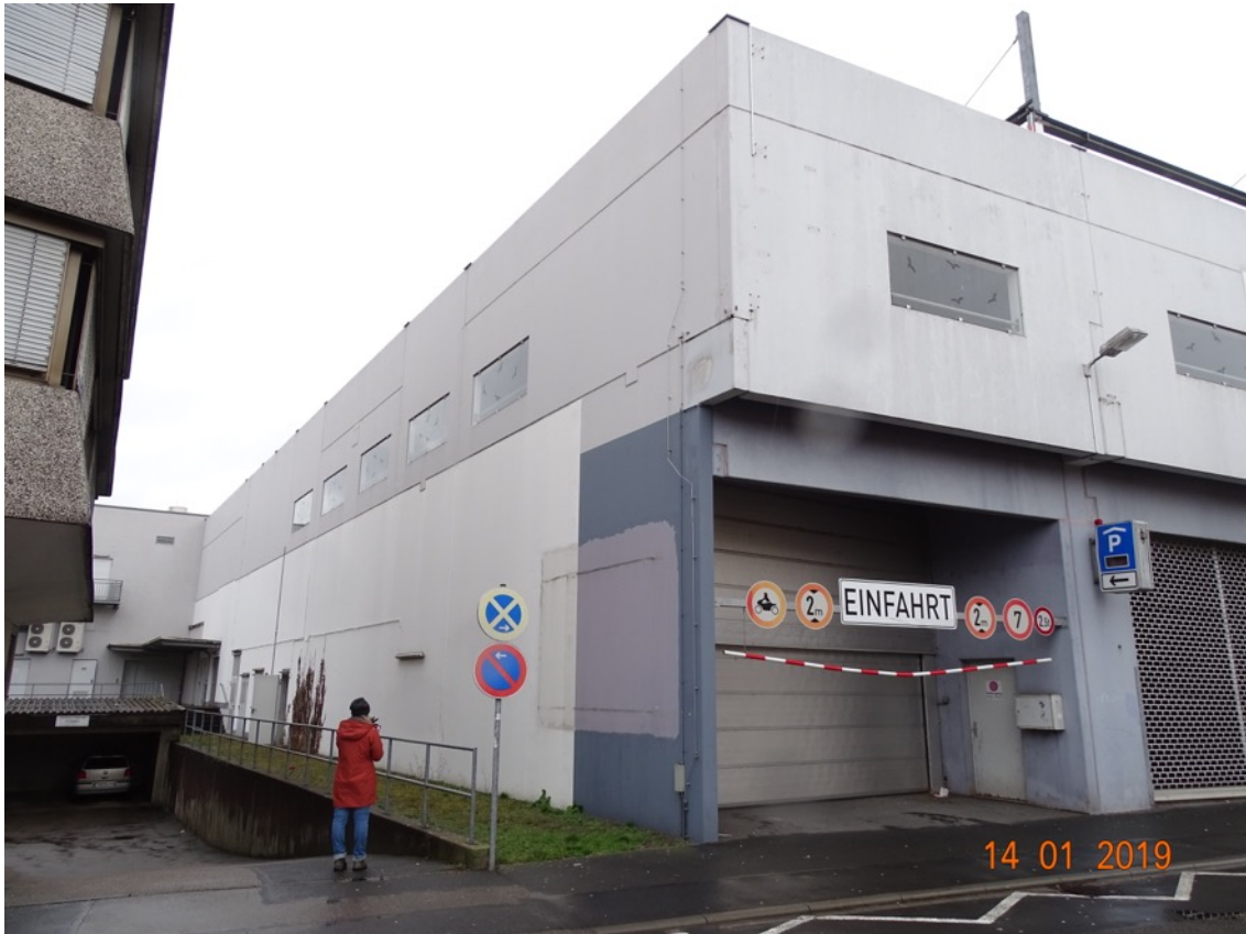
Abb. 4: Außenfassade Bereich IV, die Fassade bietet keine Fledermausquartiere oder Vogelbrutplätze
