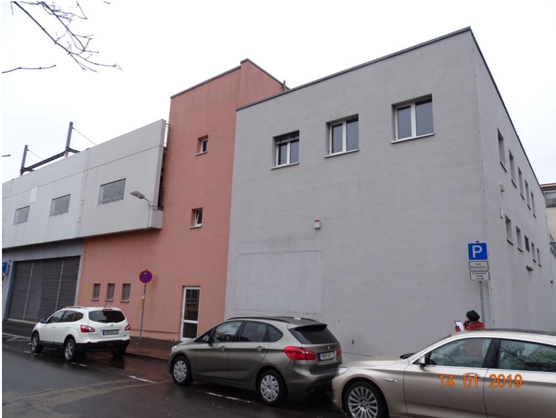
Abb. 2: Außenfassade Bereich II, die Spalten hinter Dachabschlussblechen und in Jalousiespalten sind für Fledermäuse und Vögel nicht als Quartiere bzw. Brutplätze geeignet
