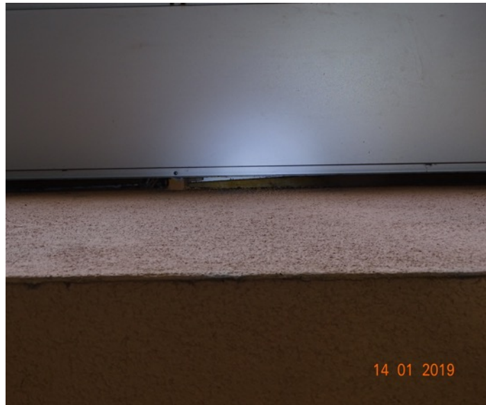
Abb. 8: Außenfassade Bereich VIII, ein etwa 3 cm tiefer und 2 cm breiter Spalt zwischen Mauer und dem Unterrand der Erkerverkleidung könnte ggf. für Fledermäuse als Sommerhangplatz geeignet sein
