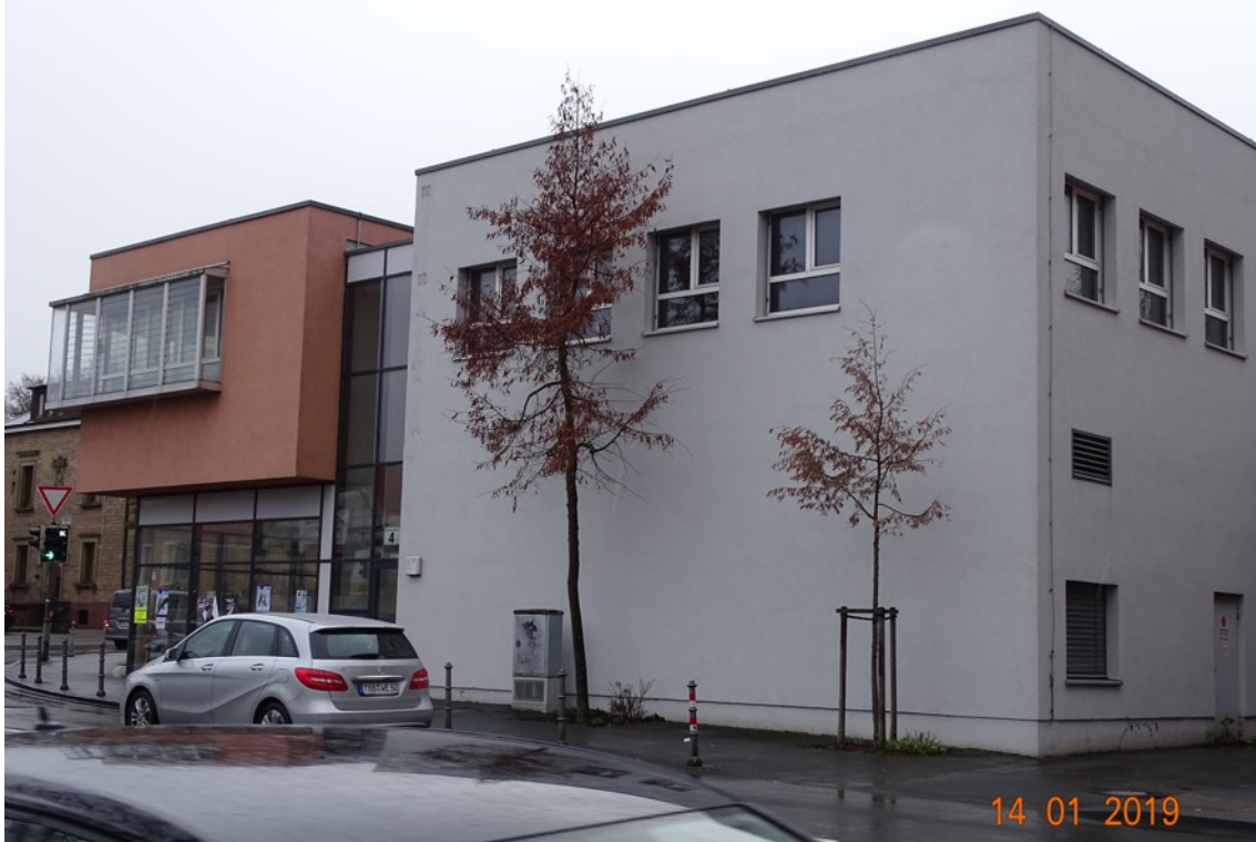
Abb. 7: Außenfassade Bereich VII, die Spalten hinter Dachabschlussblechen und in Jalousiespalten sind für Fledermäuse und Vögel nicht als Quartiere bzw. Brutplätze geeignet, die beiden Linden bieten keine Höhlen und Spalten für Fledermäuse oder Vögel
