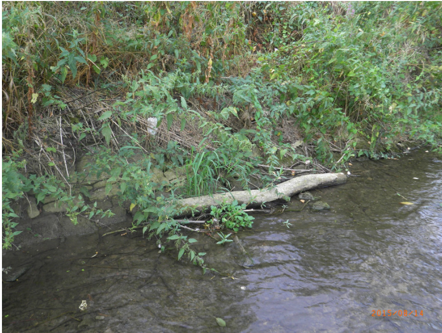
Foto 03 Steinsatz am linken Ufer [RIMG0023.jpg]
