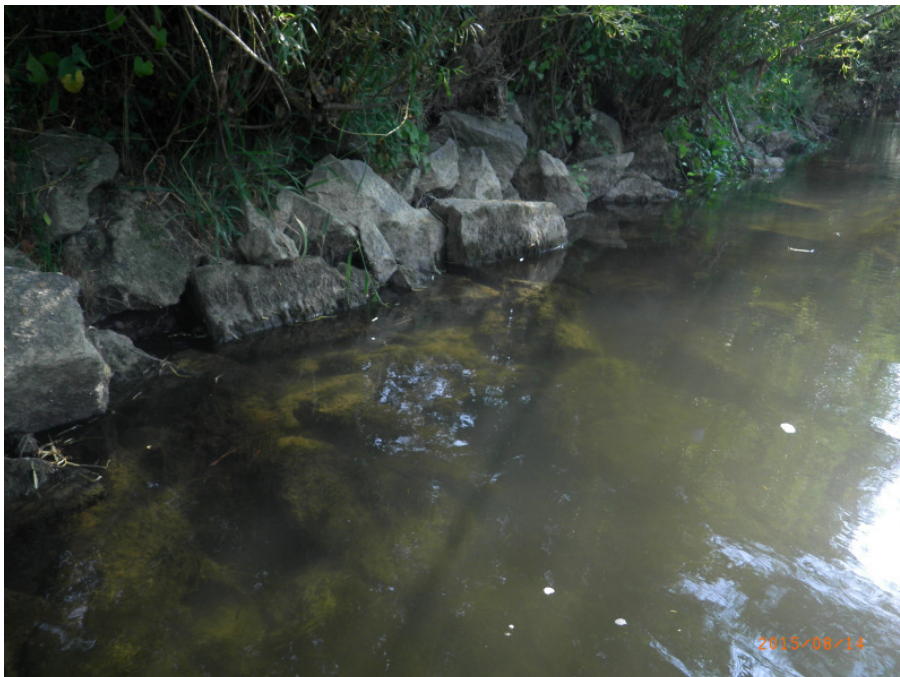
Foto 02 Blocksteinschüttung am rechten Ufer [RIMG0022.jpg]
