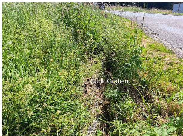
2) Südl. Graben mit Grünstrukturen © Klärle GmbH, 2024
