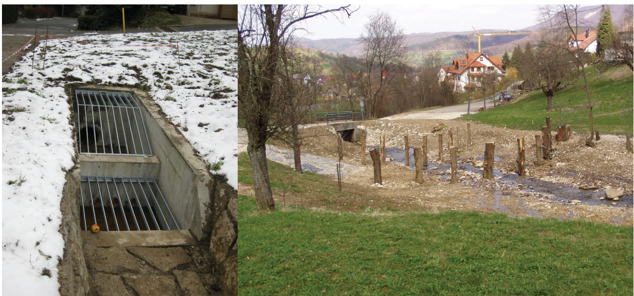
Abbildung 20: Links – Beispiel eines räumlichen Rechens, der eine Verstopfung durch Geschwemmsel und Treibgut erschwert (Wittmann, Stadt Buchen), Rechts – Verlegungsschutz mit Furt vor einem Straßendurchlass (Landratsamt Esslingen).
